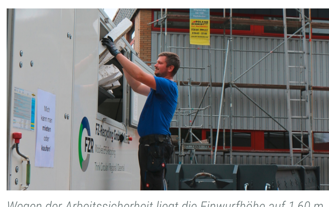
Wegen der Arbeitssicherheit liegt die Einwurfhöhe auf 1,60 m. (Quelle: DDH)
