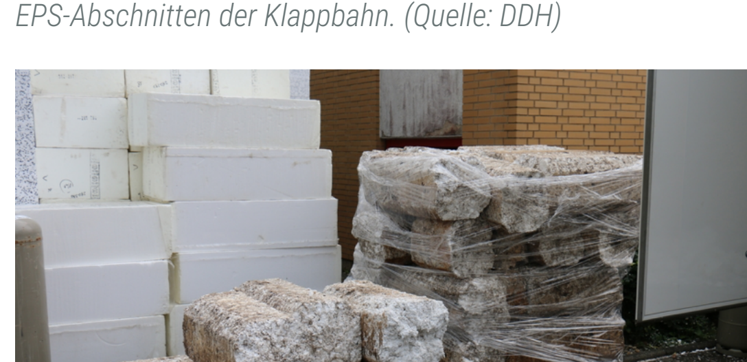
Etwa die Hälfte der Dämmung des 700 m 2 großen Schuldachs liegt auf diesen Paletten. (Quelle: DDH)
